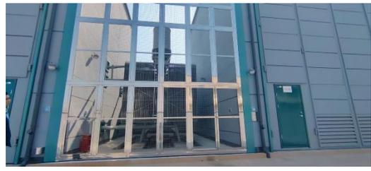
图 4-9 1#主变散热器
