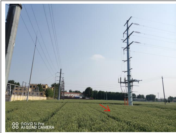
110kV长唐线入唐元站单回电缆线路北侧衰减
