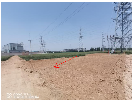
110kV长和/长尚双回电缆东南侧衰减
