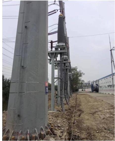
(8) A5门型塔现状
