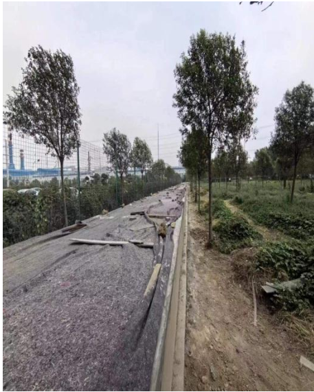
(7) 电缆管廊周边情况 (输至信源站段)
