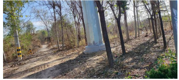
110kV 孙固线 37#附近双回架空线路材料临时 存放场地地面恢复情况
