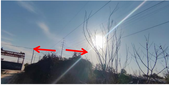
110kV 庞固线 56#~57# (110kV 孙固线 42#~43#) 杆塔之间三回架空线路南、北两侧衰减
