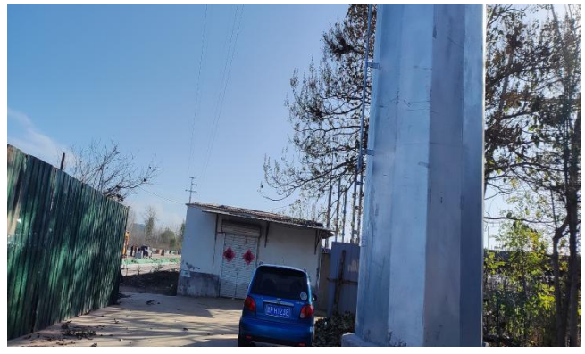
M2.110kV 庞固线 53#~54#(110kV 孙固线 39#~40; 110kV 孙北线 36#~37#) 杆塔之间边导线东侧 11 米邢八里村北侧民房
