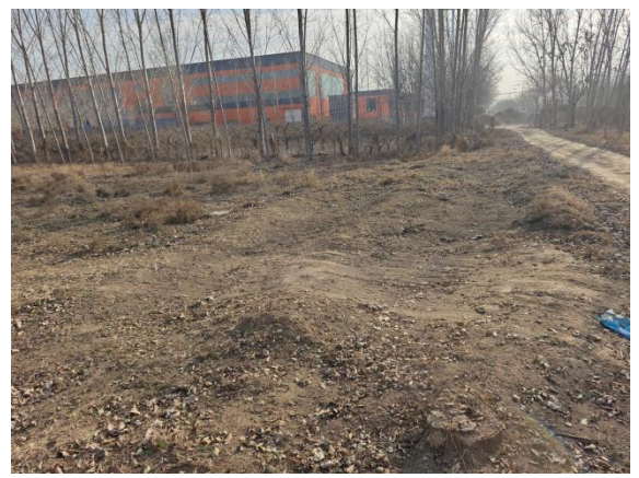
110kV 孙固线 32#附近双回架空线路牵张场地 面恢复情况
