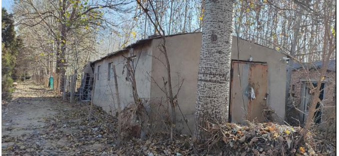
M6.110kV 庞固线 44#~45# (110kV 孙固线 30#~31#) 杆塔之间边导线线下东提固村西北侧看护房
