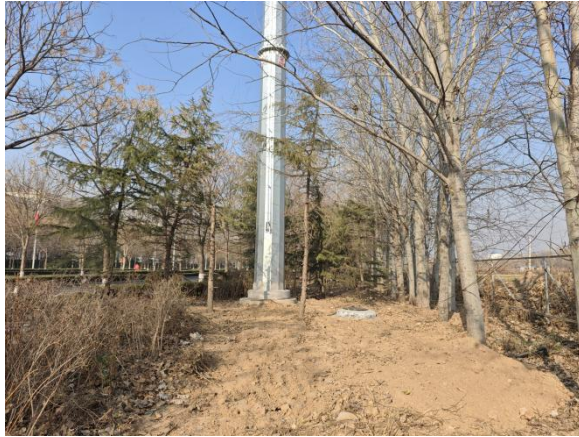
110kV 孙固线 38#附近双回架空线路牵张场地 恢复情况
