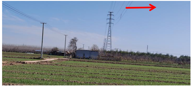
110kV 孙固线 20#~21#杆塔之间双回架空线路南侧衰减
