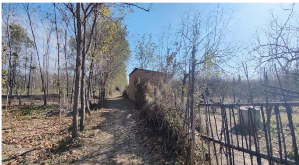
M7.110kV 原庞铁线 43#~110kV 庞固线 44#杆塔
