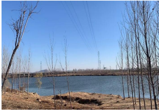
110kV红园线、红防线跨鲁南山地水土保持生态保护红线情况
