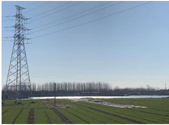
110kV红园线20#塔跨险河处塔基恢复情况
