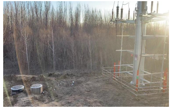
110kV红园线57#塔基恢复情况
