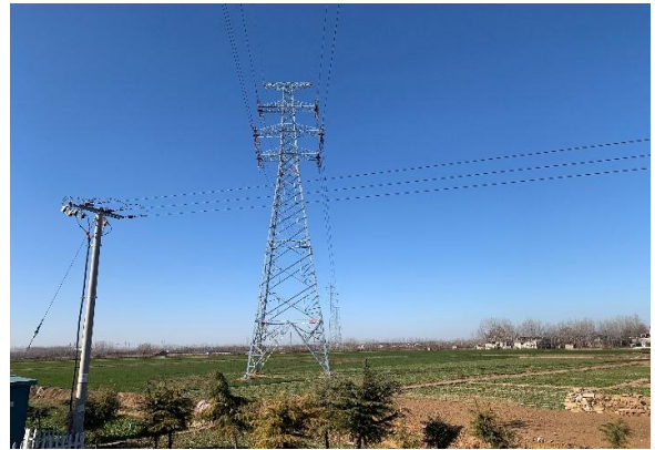
110kV红园线23#塔跨泗河处塔基恢复情况
