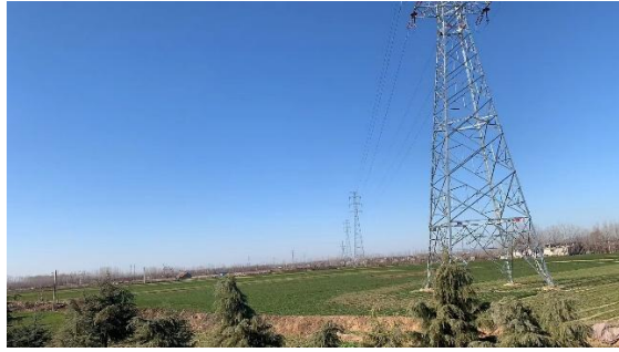
110kV红园线、红防线牵张场恢复情况
