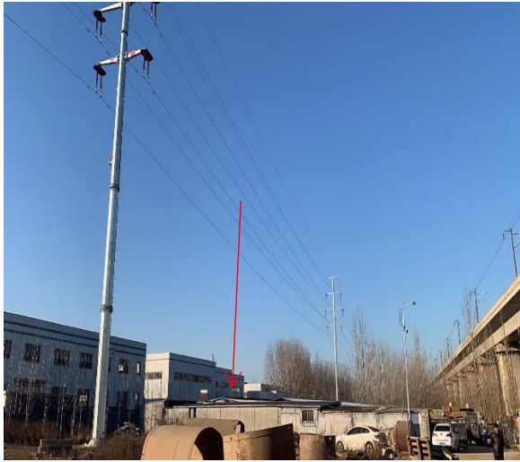
7.110kV 红园线 47#~48#(110kV 红防线 47#~48#) 杆塔边导线跨越，曲阜恒亚工贸有限公司看护房
