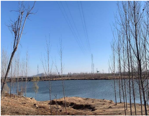
9. 110kV 红园线 (110kV 红防线 23#-24#) 跨越泗河处
